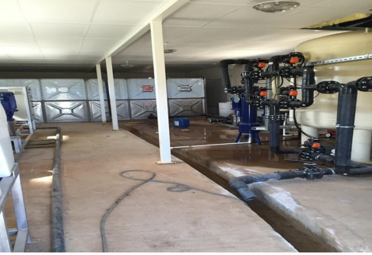
Peyzaj Otomatik Sulama Hattı Boru ve Hidroforları
