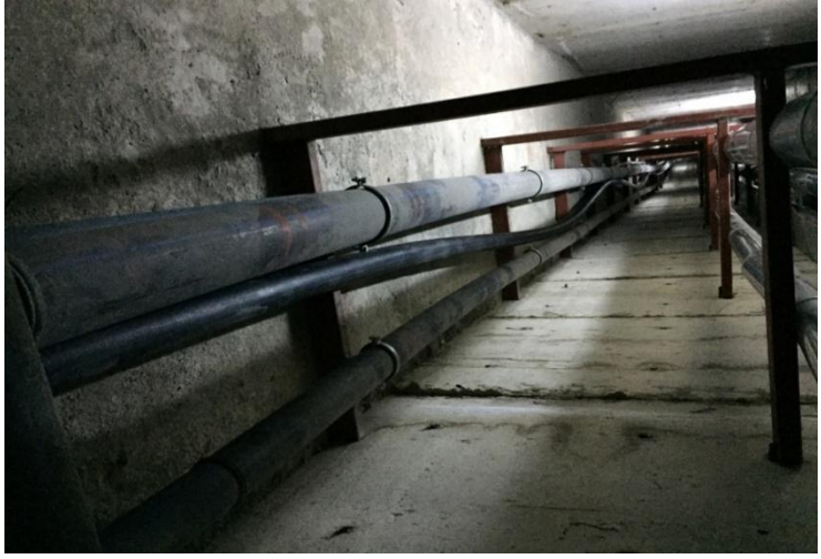
Peyzaj Otomatik Sulama Hattı Boru ve Hidroforları
