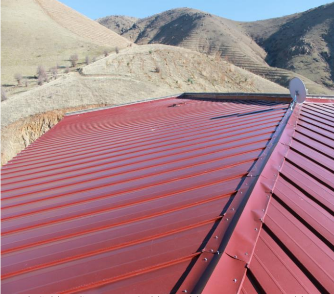
Pertek Sakine Genç M.Y.O. hizmet binasının çatısı yapıldı.
