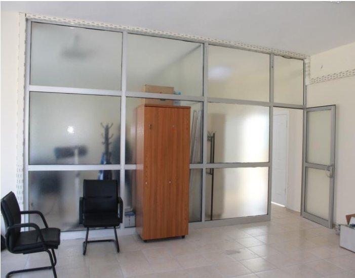
Pertek Sakine Genç M.Y.O. hizmet binasında alüminyum bölmeler yapıldı.
