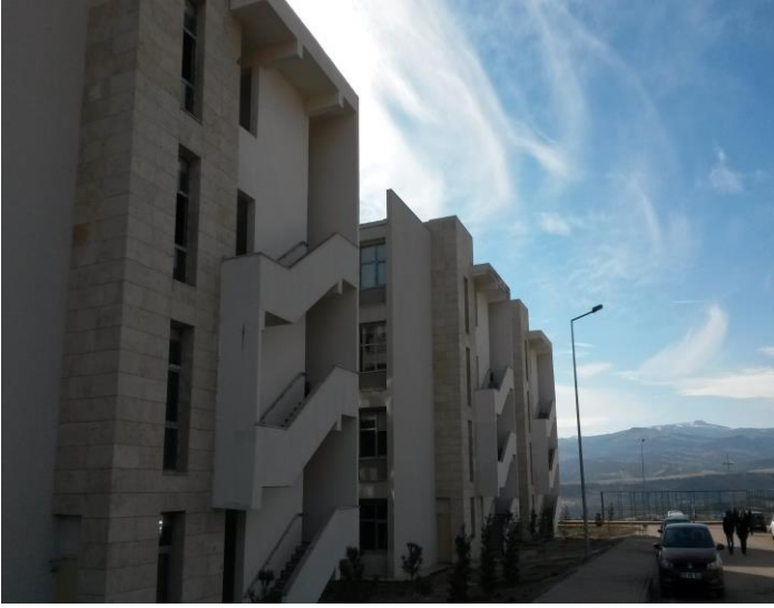
Aktuluk yerleşkemizdeki binaların yangın merdivenlerinin sudan korunması için üstü kapatıldı.
